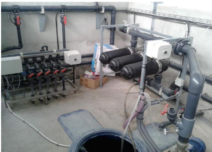
**Fig. 23** - Depósito de água e sistema doseador da solução nutritiva (lado esquerdo)
